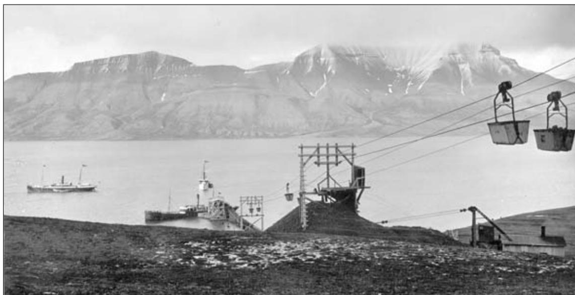
ケーブル・ゴンドラによる石炭の運搬（ロングヤー・ビーエン、アーキーヴの写真から）。
