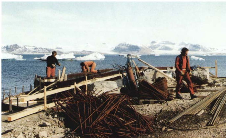
Fig. 97. Den nye kaien i Ny-Ålesund ble bygget som en festning av tungt armert betong for å kunne motstå angrep av drivende isfjell i fjorden. Bildet ble tatt i 1990. (V.H.)
