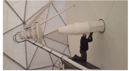
Ny feed er på plass, Aleks kontrollerer innfestingen
