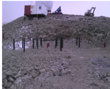
H-bjelkene er satt ned og støpt fast
