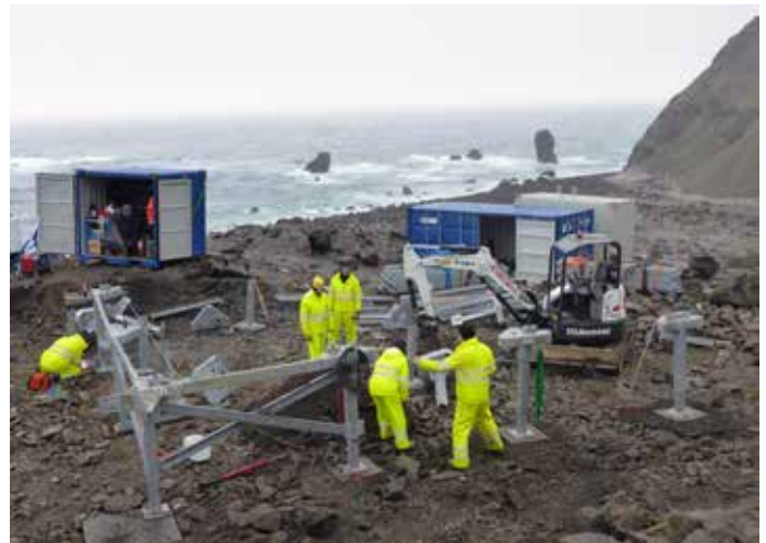
NY FELTSTASJON/NEW FIELD STATION Montering av den nye feltstasjonen på Bouvetøya/Installation of the new field station on Bouvet Island. Foto/Photo: Marius Bratrein NP/NPI
