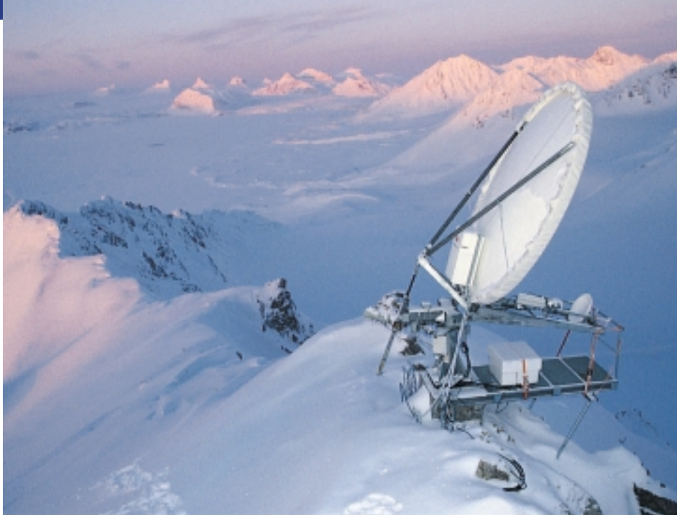
Fra luftmålestasjonen på Zeppelinfjellet i Ny-Ålesund.
