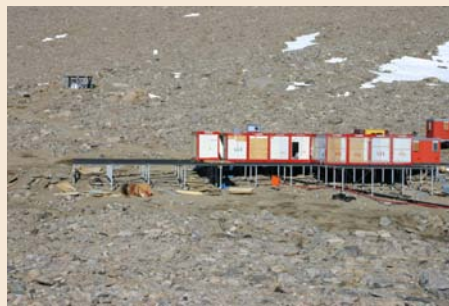
Helårsstasjonen under bygging 12. januar 2005
