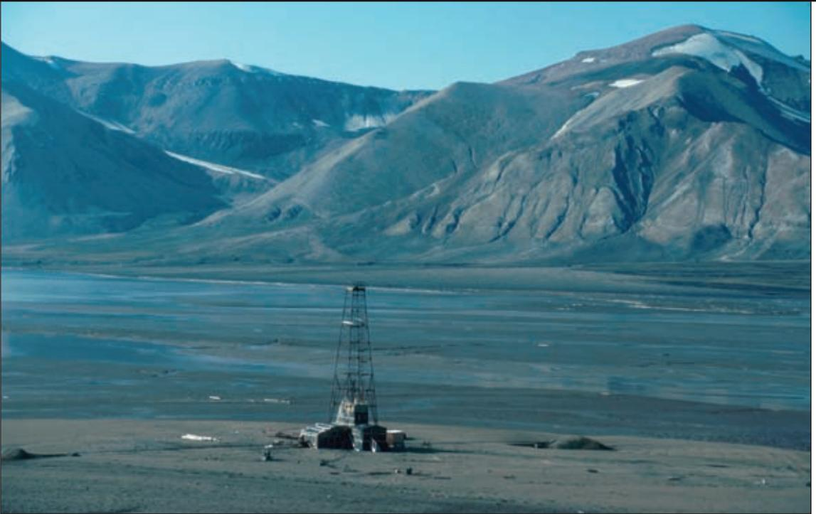
Russische Bohrplattform im Billefjord. Während Prospektionsbohrungen nach Kohle erfolgte 1991 ein Gasausbruch, bei dem geringe Mengen von Erdöl an die Erdoberfläche gelangten. Foto: W. Dallmann
