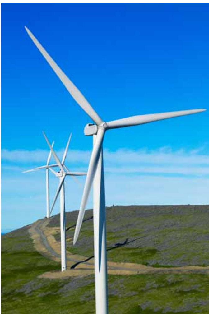
Havøygavlen Vindpark i Havøysund, Finnmark. Foto: © Bård Løken, Samfoto
