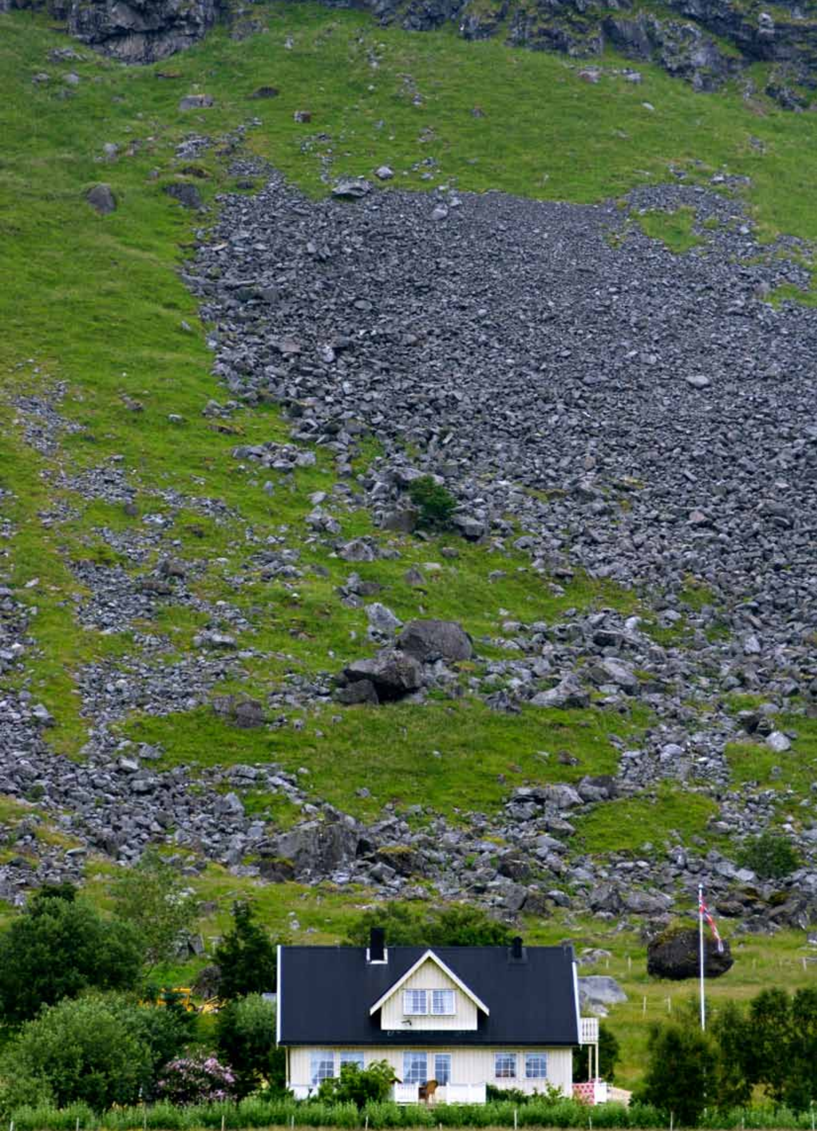
Enebolig i rasutsatt område i Vestvågøy kommune, Lofoten. Foto: © Dag Røttereng, Samfoto
