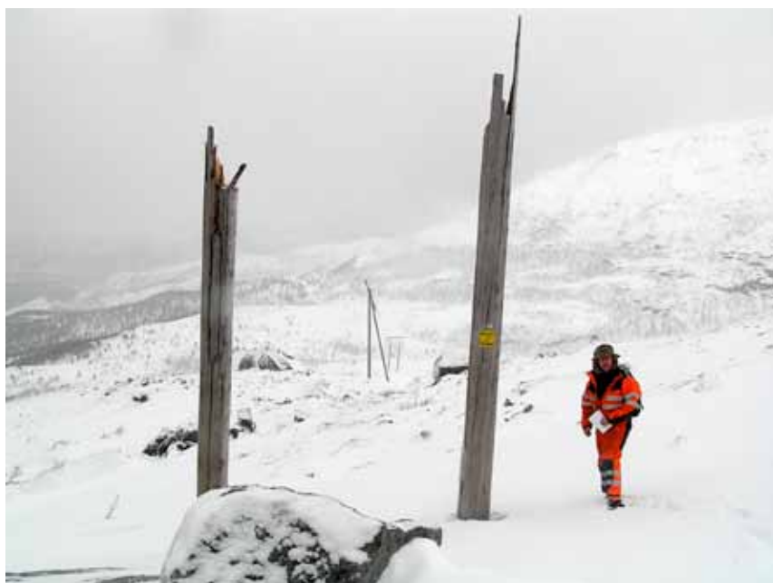
Strømbruddet i Steigen kommune i januar 2007, som gjorde 1097 husholdningskunder, 134 næringslivskunder og 587 hyttekunder strømløse i nærmere seks døgn, er et eksempel på hvordan eldre og/eller dårlig vedlikeholdt kraftforsyningsinfrastruktur kan være sårbare for ekstreme værhendelser. Her var det sterk vind som var utløsende for direkte skader på linjer og master, samt indirekte via trefall, som førte til brudd på ledningene på distribusjonsnettet. Foto: Nord-Salten Kraftlag
