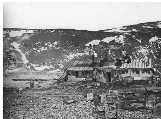
Borchgrevinks overvintringsstasjon på Cape Andre Adare, fotografert nyttårsaften 1900. Bygningen var prefabrikkert på Strømmen Trævarefabrik og var den første bygningen reist på et kontinent som fremdeles står. Foto: C. Borchgrevink, Norsk Polarinstittutt
