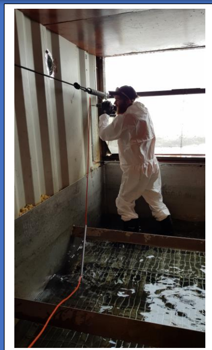
Geir monterer varmekabel
