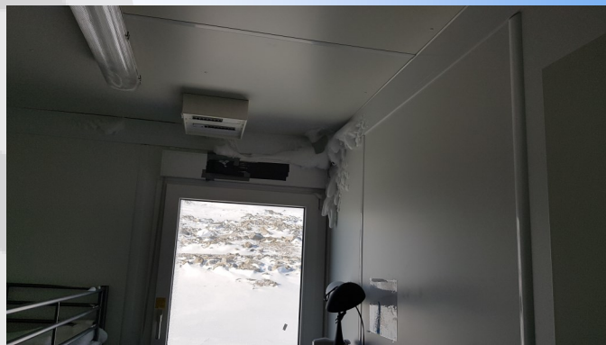
Snøen hang i tak og sprekker.
