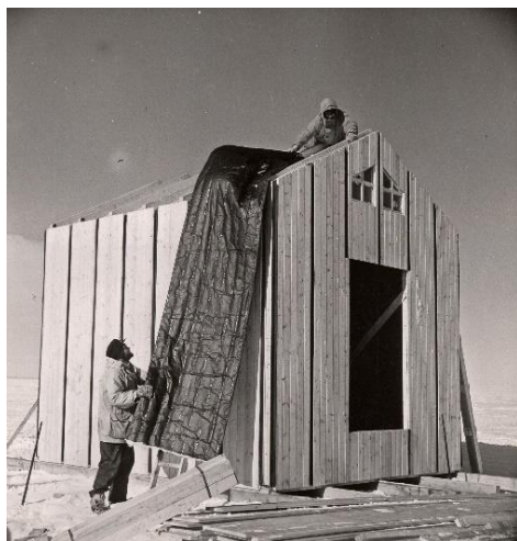
Bygging av Rawinhytta under Maudheim-ekspedisjonen til Antarktis. Foto: V. Schytt, Norsk Polarinstituttts bildearkiv. 1950.
